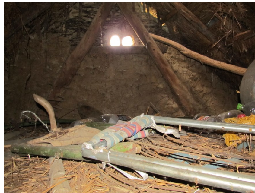
VESSZŐFONATOS, VÁLYOGTAPASZTÁSÚ, SZELLŐZŐNYÍLÁSOS OROMFAL
