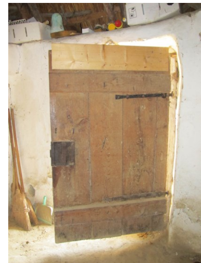
PRÉSHÁZ BEJÁRATI AJTÓ BELSŐ OLDALA
