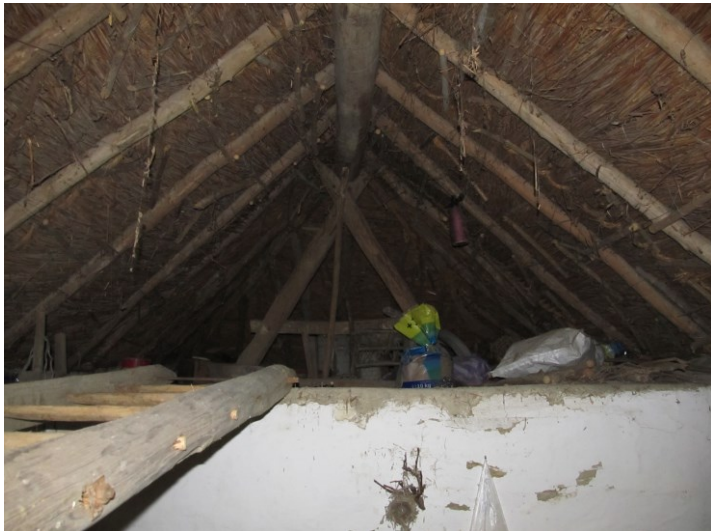
OLLÓÁGAS SZELEMENES FEDÉLSZÉK
