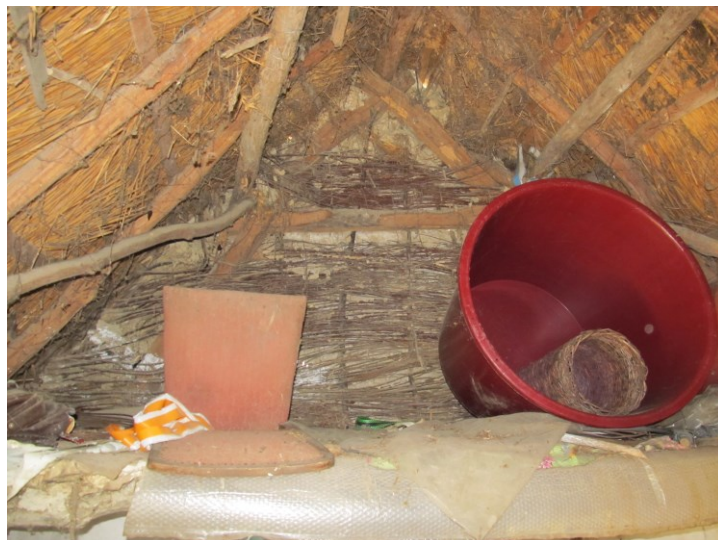
VESSZŐFONATÚ, VÁLYOGTAPASZTÁSÚ OROMFAL
