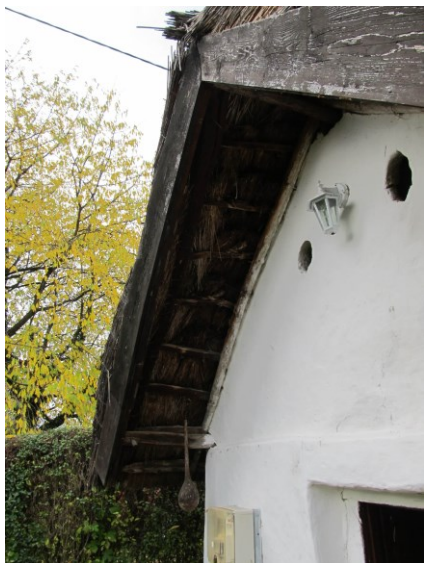
ROZSSZALMA ZSUPFEDÉS AZ UTÓLAGOS NÁDFEDÉS ALATT
