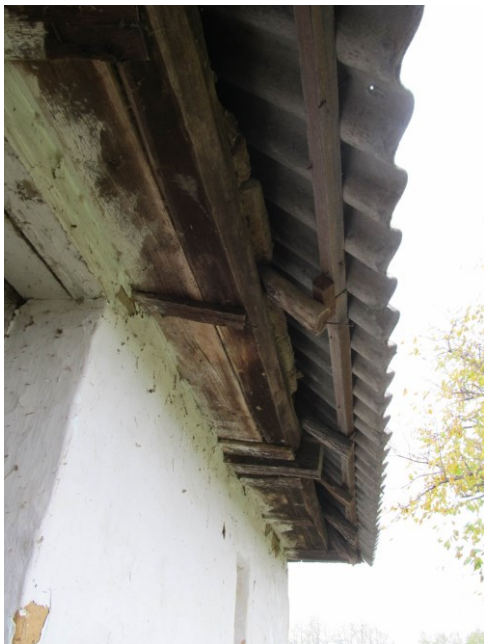
BEJÁRATI OLDALI TETŐSZERKEZET HOMLOKZATI TÚLNYÚLÁSA
