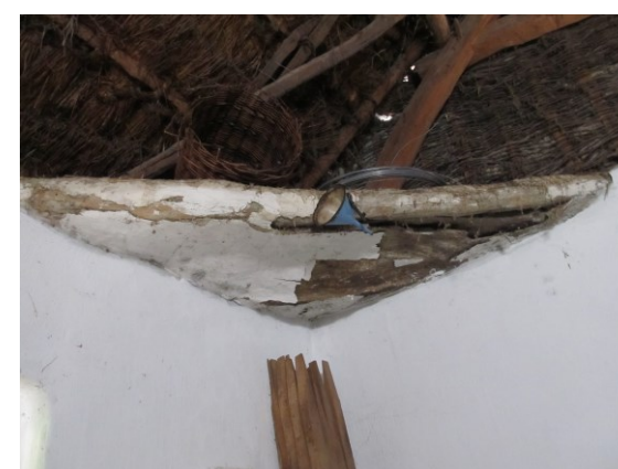
PRÉSHÁZ SARKÁBAN KIALAKÍTOTT EGYKORI SZIKRAFOGÓ
