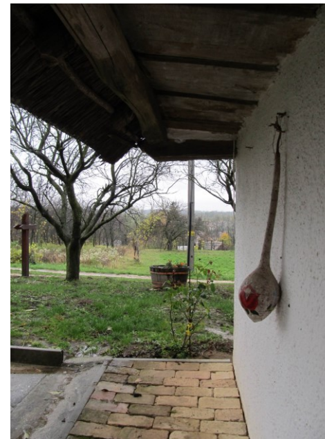
BEJÁRATI OLDALI TETŐSZERKEZET HOMLOKZATI TÚLNYÚLÁSA
