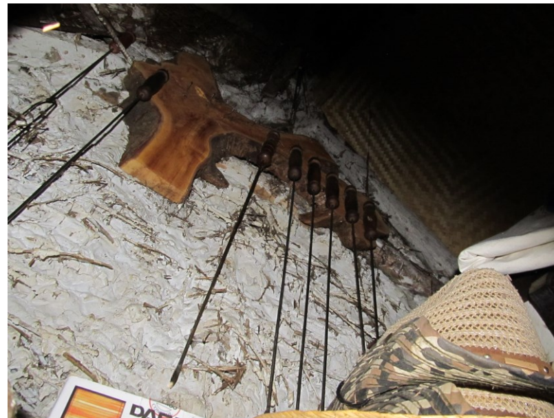
PRÉSHÁZ VÁLYOGTAPASZTÁSÚ OROMFALA
