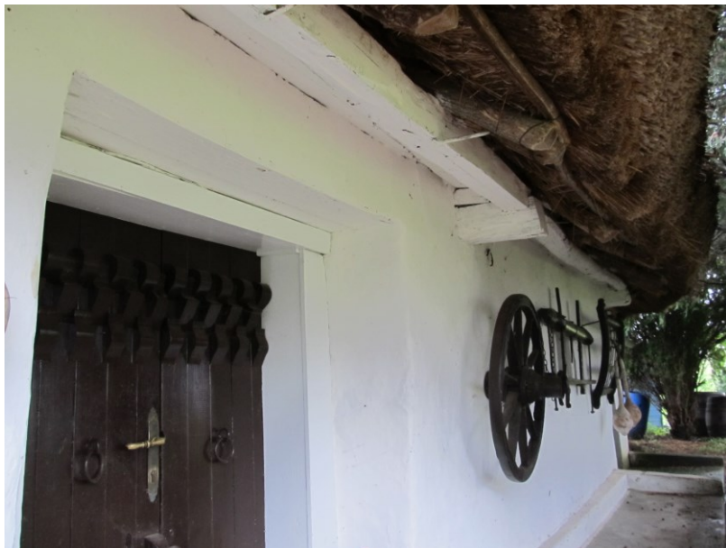
BEJÁRATI OLDALI TETŐSZERKEZET HOMLOKZATI TÚLNYÚLÁSA
