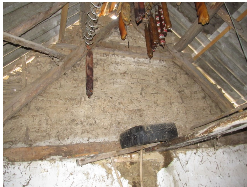
VESSZŐFONATOS, VÁLYOGTAPASZTÁSÚ OROMFAL
