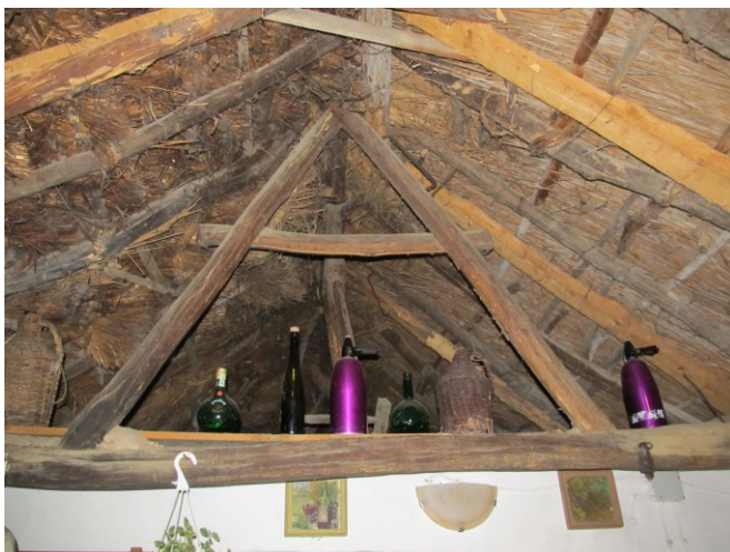
OLLÓÁGAS, SZELEMENES TETŐSZERKEZET EGYIK TETŐSÍKJÁN NÁDDAL FELÜLFEDETT ROZSSZALMA ZSUPFEDÉSEL MÁSİK TETŐSÍKJÁN NÁDFEDÉSEL
