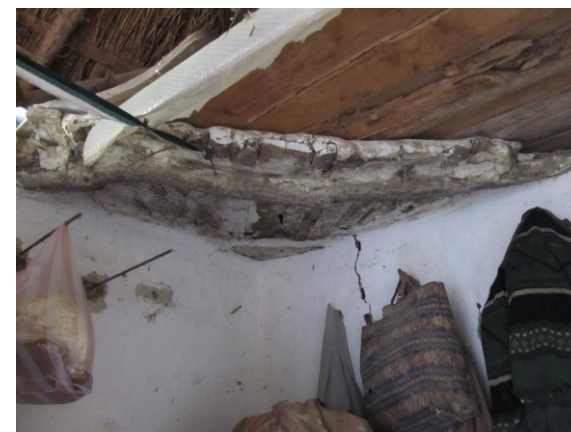
PRÉSHÁZ SARKÁBAN KIALAKÍTOTT EGYKORI SZIKRAFOGÓ
