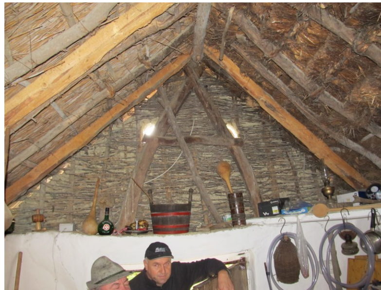
VESSZÓFONATÚ, VÁLYOGTAPASZTÁSÚ, SZELLŐZŐNYÍLÁSOS OROMFAL
