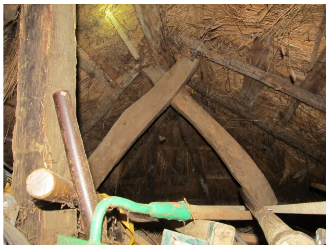
OLLÓÁGAS SZELEMENES TETŐSZERKEZET
