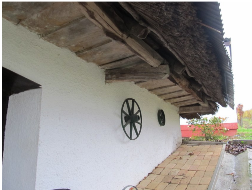
BEJÁRATI OLDALI TETŐSZERKEZET HOMLOKZATI TÚLNYÚLÁSA
