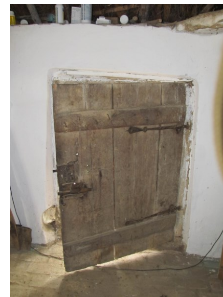
PRÉSHÁZ BEJÁRATI AJTÓ BELSŐ OLDALA
