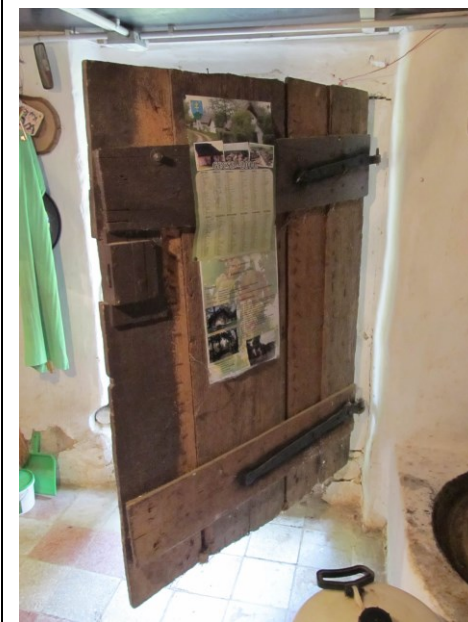
PRÉSHÁZ BEJÁRATI AJTÓ BELSŐOLDALA
