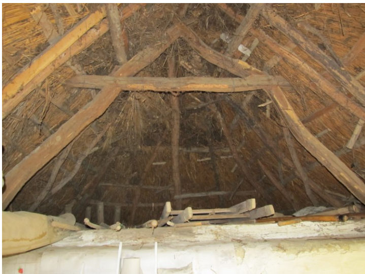
OLLÓÁGAS, SZELEMENES TETŐSZERKEZET
