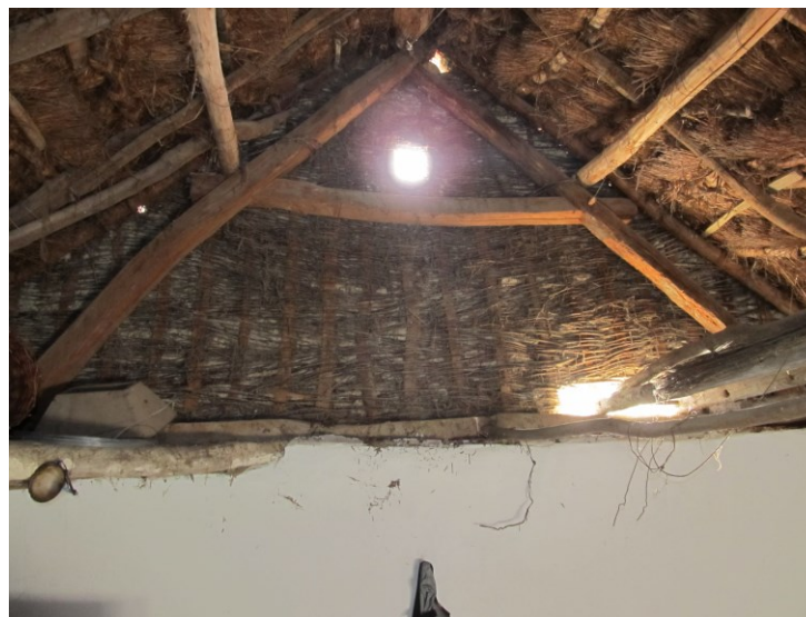
VESSZÓFONATÚ, VÁLYOGTAPASZTÁSÚ, SZELLŐZŐNYÍLÁSOS OROMFAL
