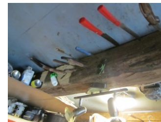
PRÉSHÁZ FELETTI FAGERENDÁS FÖDÉM ÚJKORI UTÓLAGOS ÉPÍTŐLEMEZ BORÍTÁSSAL
