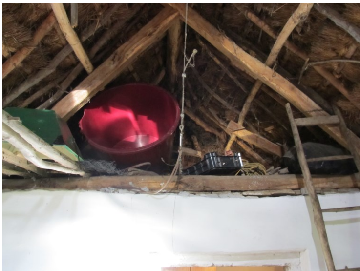
OLLÓÁGAS, SZELEMENES TETŐSZERKEZET
