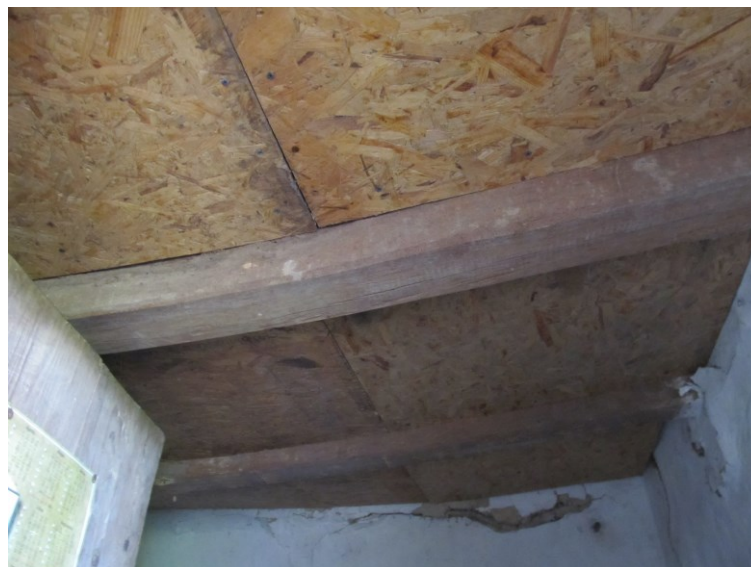
PINCE FELETTI FAGERENDÁS FÖDÉM UTÓLAGOS MEGERŐSÍTÉSSEL
